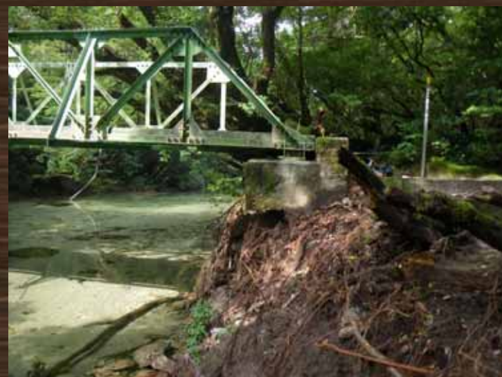
土砂流出直後の淀川歩道橋の状況
