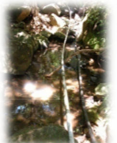
取水用パイプ
