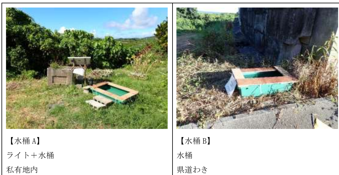
図 2-10 水桶設置状況
