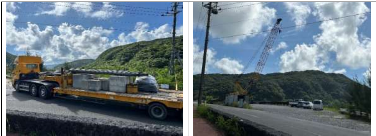
図 2-12 工事現場への運搬状況（浦内橋）
