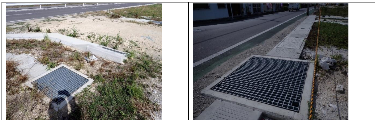
図 4-9 新設された集水枡の状況
