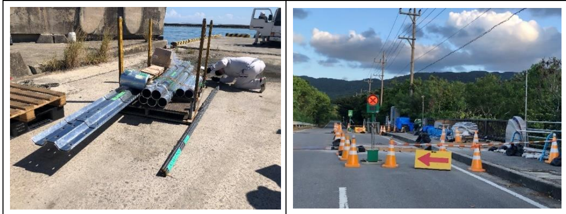
図 2-9 資機材の状況（上段：仲間港入港時、下段：工事現場（西ゲータ橋）状況）
