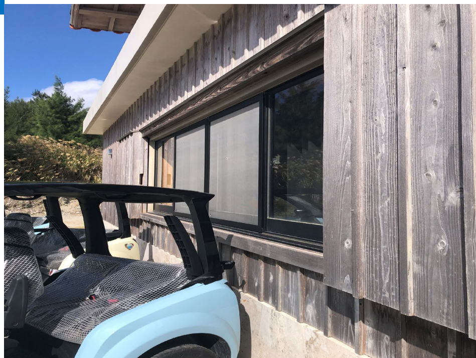
外壁木材の劣化・釘浮き
