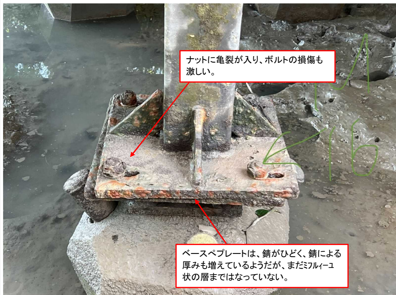
ボルトが錆び、ナットに亀裂が走っている、ボルトの耐力が無くなってきており、ナットも簡単に外れる(折れる)ので、非常に危険な状況である。要交換。 ベースプレートは、錆がひどいが、プレートの厚みもあるので、早急に防錆処理が必要。
