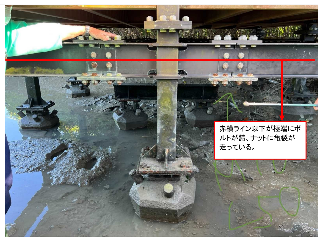
浸水エリアは極端に、ボルトが錆、ナットに亀裂が走っている、ボルトの耐力が無くなってきており、ナットも簡単に外れる(折れる)ので、非常に危険な状況である。要交換。
