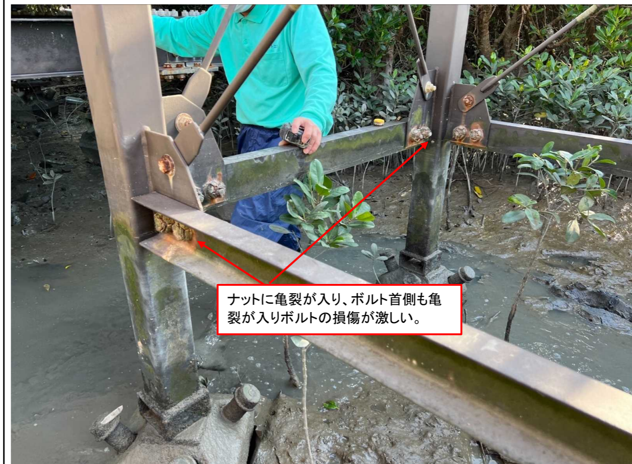
ボルトが錆び、ナットに亀裂が走っている、ボルトの耐力が無くなってきており、ナットも簡単に外れる(折れる)ので、非常に危険な状況である。要交換。
