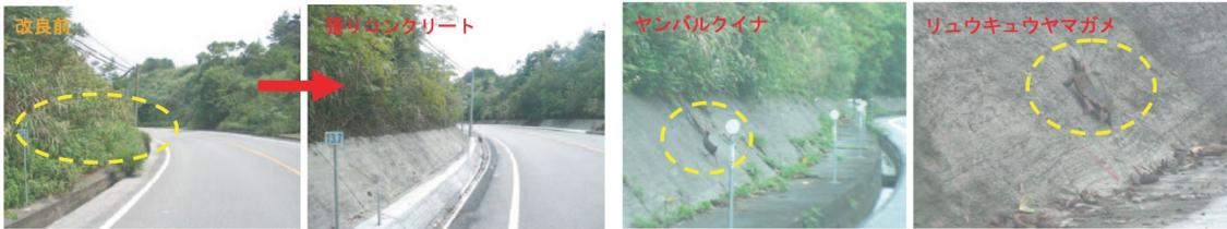
図 21. 法面の張りコンクリート化と改良した張りコンクリート法面を上るヤンバルクイナとリュウキュウヤマガメ（沖縄県北部土木事務所維持管理班、2010）。
