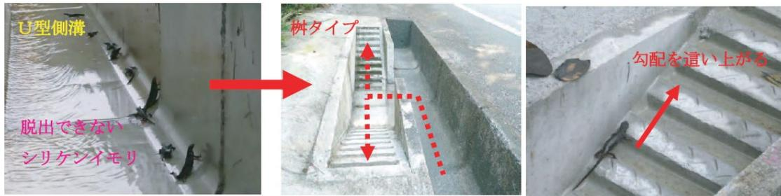
図 22. 片側勾配側溝及び樹タイプ側溝への改良。いずれも動物が森林側へ脱出できるよう改良されており、実際にリュウキュウヤマガメやシリケンイモリが勾配を這い上がる様子が確認されている（沖縄県北部土木事務所維持管理班、2010）。
