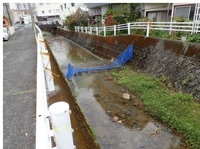
⑨作業地点の下流に設置された拡散防止用ネット
