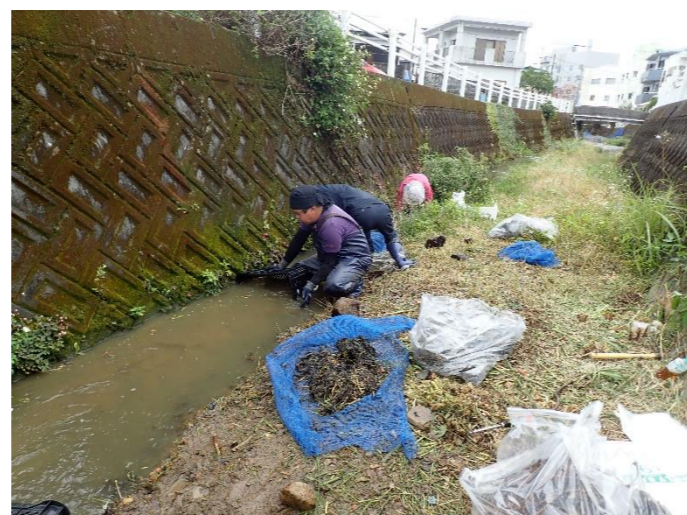
⑩⑪作業地点直下の拡散防止措置(2重のネット+断片回収用人員)
