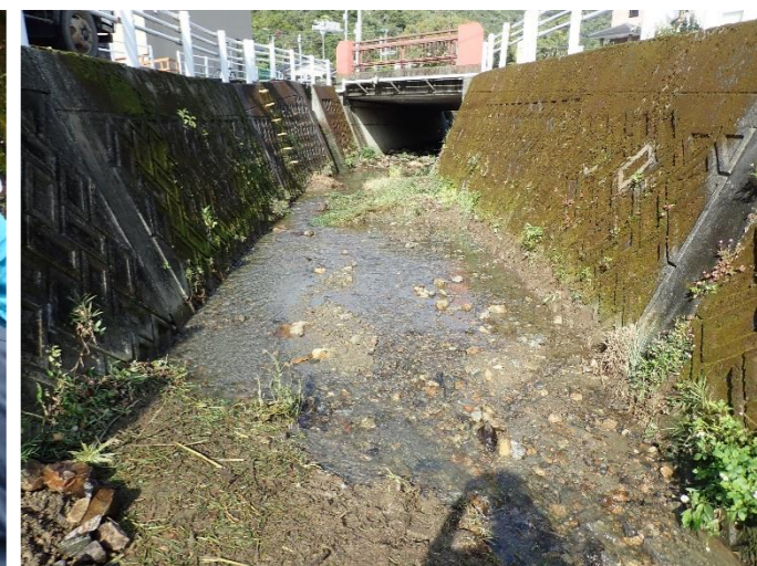
⑧「根を含む堆積層」をすべて水で溶かした後 (より堅い下層の堆積層が残る)
