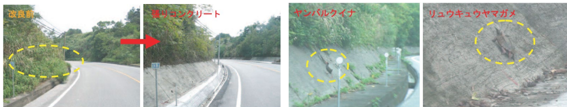
図 21. 法面の張りコンクリート化と改良した張りコンクリート法面を上るヤンバルクイナとリュウキュウヤマガメ（沖縄県北部土木事務所維持管理班、2010）。
