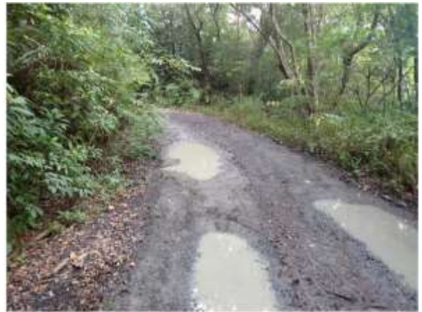
図 2. 金作原 2022 年 3 月の砂利入れ・転圧後、再度水溜りが生じていた地点 (2023 年 8 月時点)
