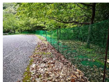
図 18. 奄美大島の湯湾岳周辺（7）の一部の道路区間に施工された進入抑制フェンス。
