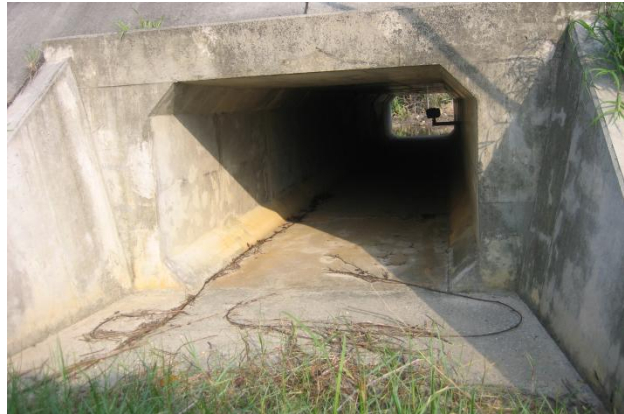
図3-20 道路構造の改良：幹線道路へのアンダーパスの設置（写真：自然環境研究センター）
