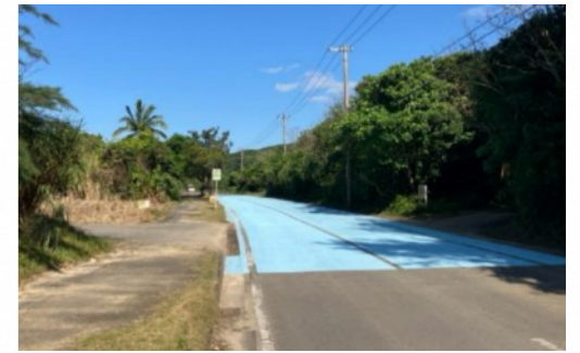
路面カラーリングの様子
