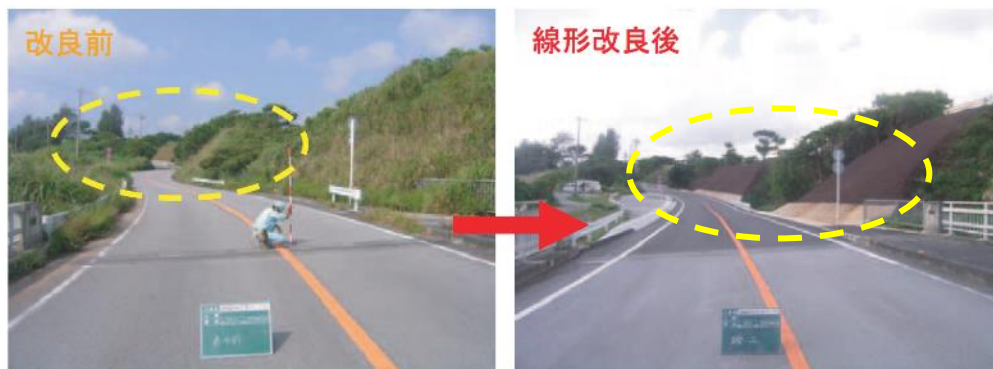
図 13. 線形改良工事の前後での変化。
