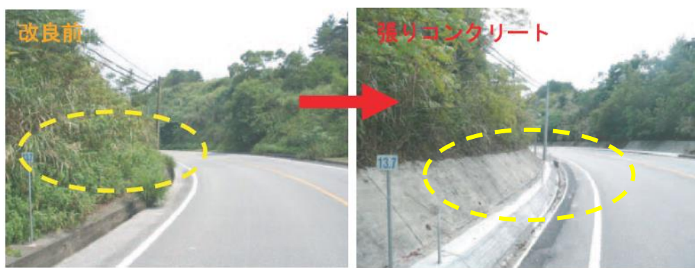
図10. 法面の張りコンクリート化。
