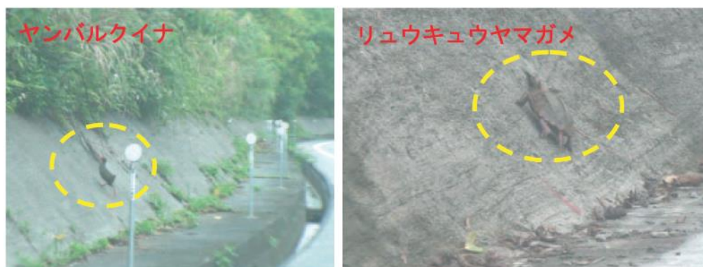
図11. 改良した張りコンクリート法面を上るヤンバルクイナとリュウキュウヤマガメ。
