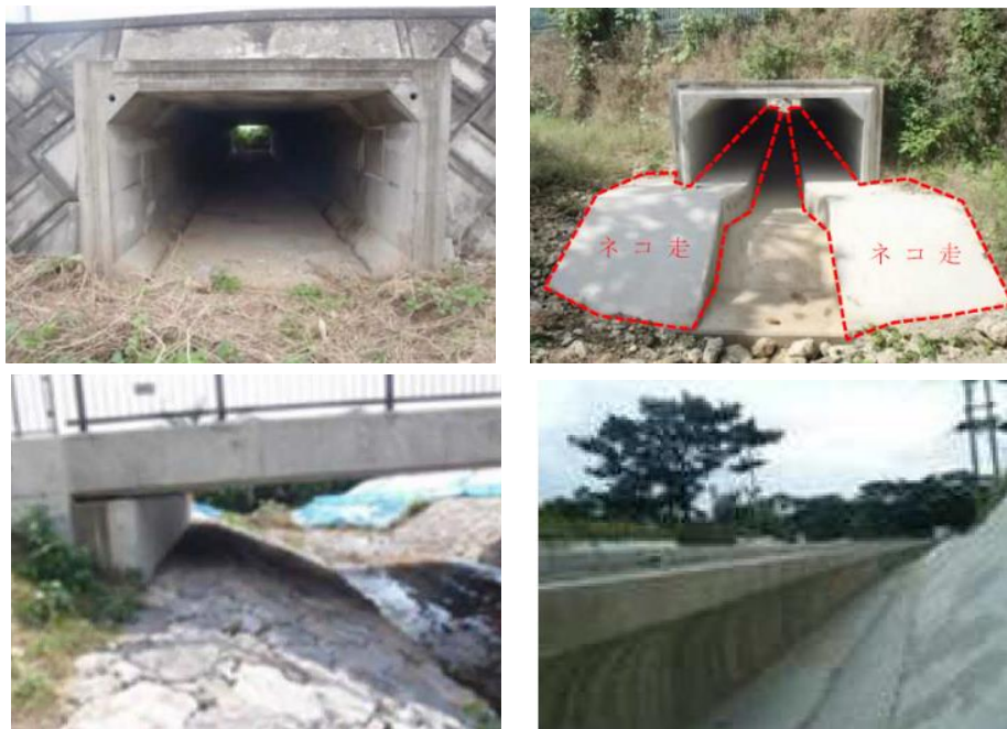
図14. アンダーパス等の構造（左上：動物専用タイプ、上右：排水兼用タイプ、左下：橋梁桁下通路、右下：片勾配側溝）。
