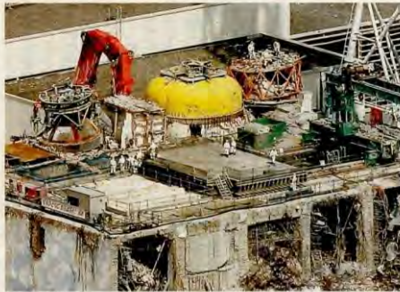
建屋が取り除かれ、燃料プール(手前)や原子炉格納容器のふたが露出した福島第一原発4号機=23日、本社ヘリから、堀英治撮影
