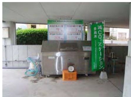
1号機: 武道館駐車場
