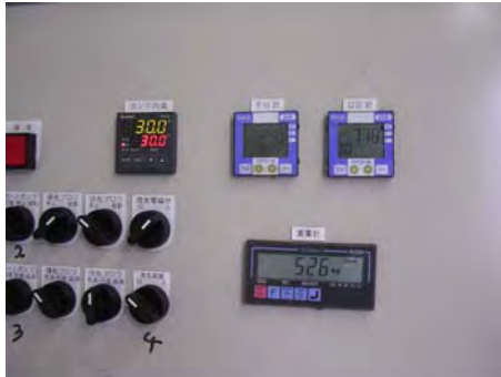
写真9 遠隔監視制御盤
