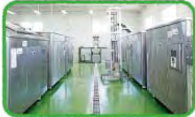
写真3 メリーズシステムリサイクルセンター
