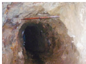
代替横坑内部
