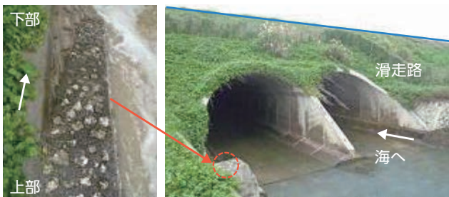
生物の移動が可能な 滑走路下のアーチカルバート スロープ
