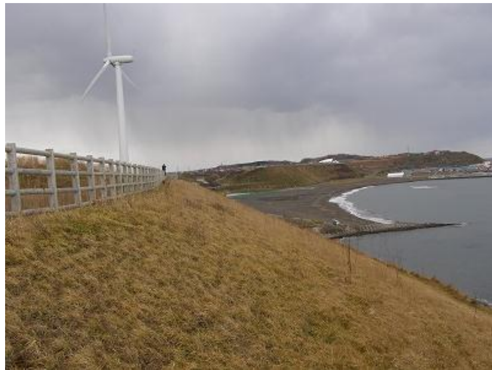
北海道苫前町 夕陽ヶ丘風力発電所
