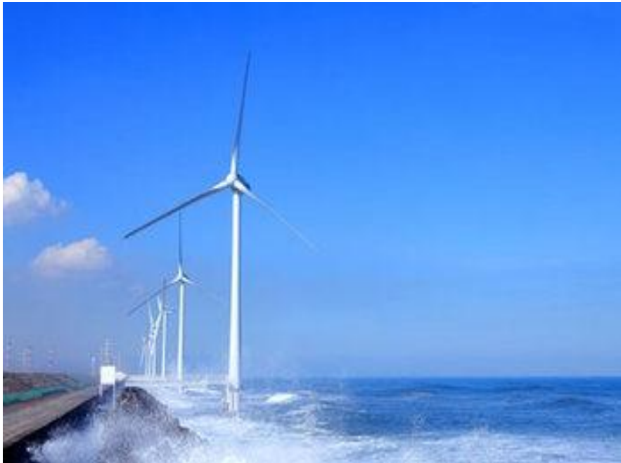
ウインド・パワーかみす洋上風力発電所
