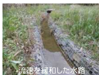
流速を緩和した水路
