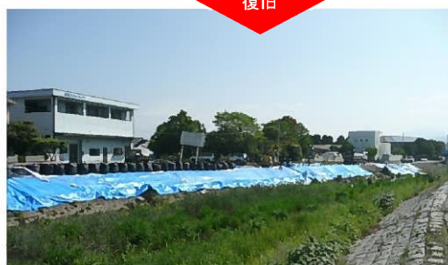
シート張り工及び大型土のう積み工完了 (平成28年5月18日)
