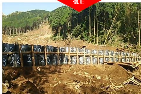
応急対策完了(平成28年4月24日)
