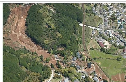
被災状況(平成28年4月16日撮影)
