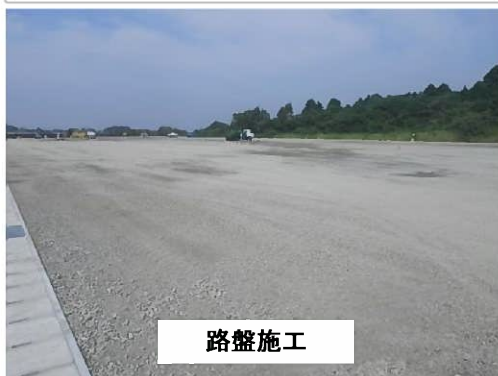
仮置ヤードの舗装
