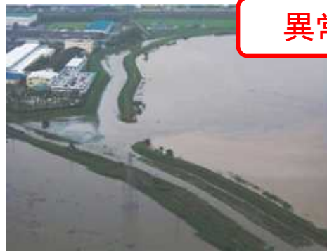
図： 洪水被害の事例(愛知県 広田川) (写真提供：国土交通省中部地方整備局)
