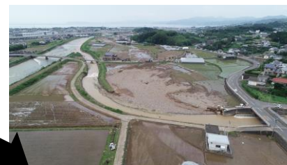
←令和2年7月豪雨による大村市内の河川氾濫
