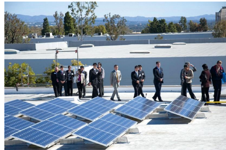
2011年 米・カリフォルニア生産拠点 太陽光発電システム設置
