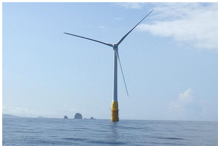
既設風車の外観 (H28.10.1撮影)
