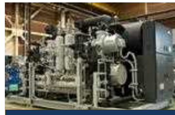
高効率冷凍機 (前川製作所)
