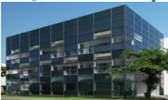
ZEB (例：大成建設実証棟)
