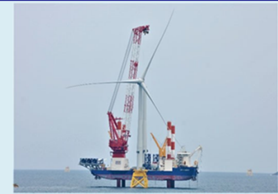
風車運搬・据付
