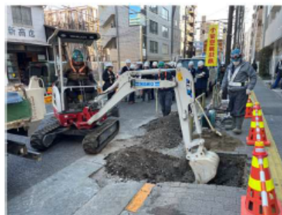
GX建機の実現場での活用事例
