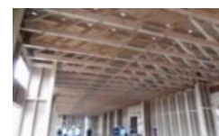
製材による大規模トラス
