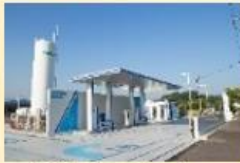
水素ステーション
