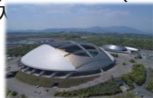
広域防災拠点である大分スポーツ公園
