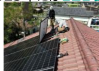
地元事業者による施工の様子
