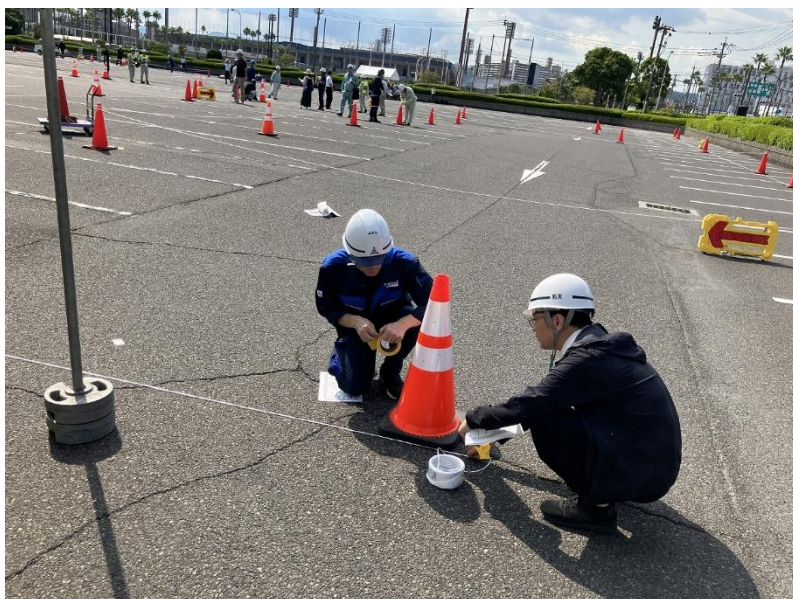
仮置場設置の様子
