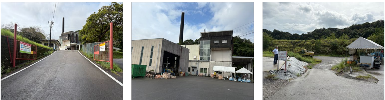
写真 左：清掃工場出入口のゲート、中：中継施設の状況、右：仮置場候補地に下りるスロープ
