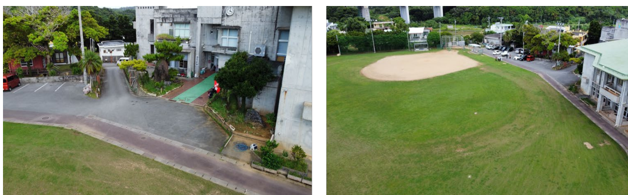
写真 左：グラウンド進入路付近の様子、右：グラウンドの全景2
