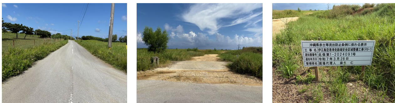
写真 左：県道 225 号、中：処分場の出入口（県道側から撮影）、右：処分場の看板
