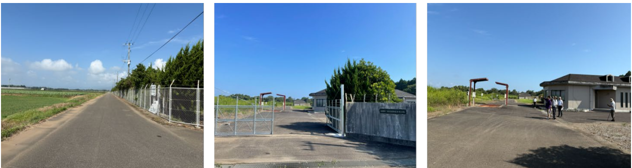
写真 左：最終処分場に面する道路、中：最終処分場の出入口、右：入場後（管理棟、台貫跡）
