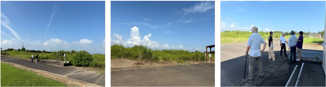
写真 左：最終処分場内のポンプ施設、中：最終処分場の状況、右：現地調査の様子
