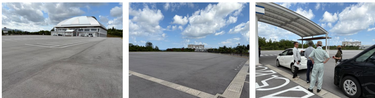
写真 左：駐車場の地面の様子1、中：駐車場の地面の様子2、右：現地調査の様子
