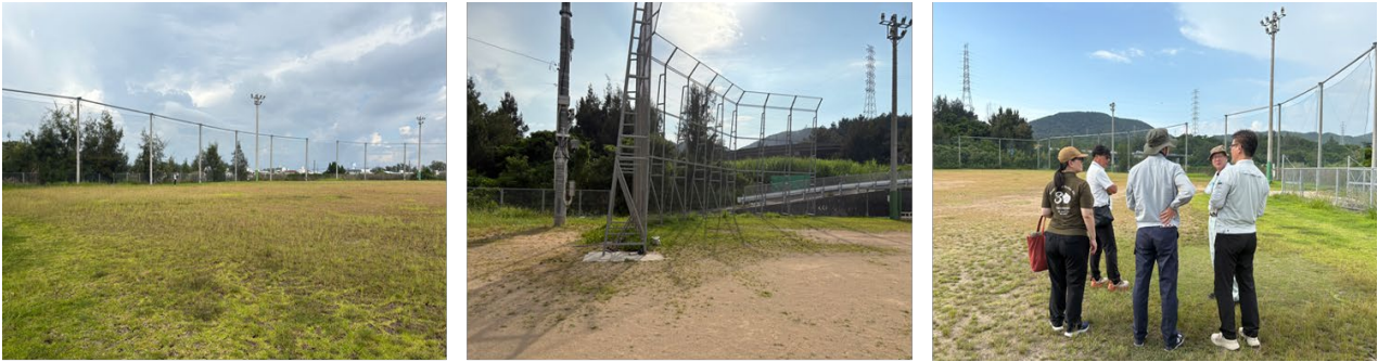
写真 左：グラウンドの地面の状況 1、中：バックネット付近の状況、右：現地調査の様子
