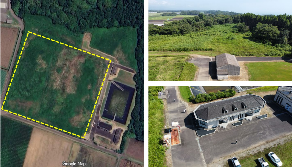
写真 左：高鍋町一般廃棄物最終処分場の航空写真（GoogleMaps より作成） 右上：最終処分場の様子、右下：最終処分場管理棟付近
