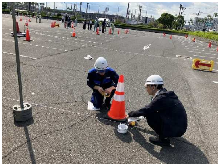
仮置場設置の様子
