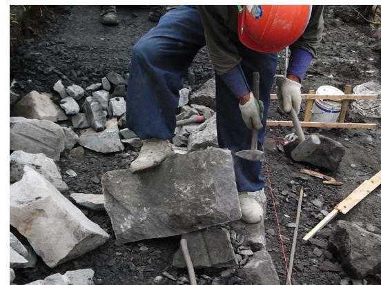
江戸城跡の石垣修復工事
