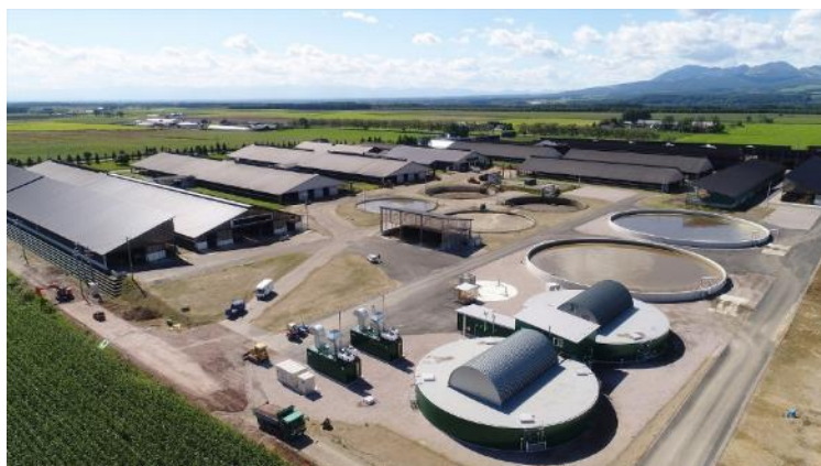
バイオガスプラント
