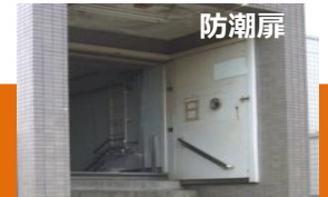
地下鉄出入口の浸水対策
