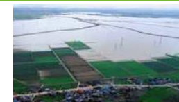
集中豪雨による農地の湛水被害
