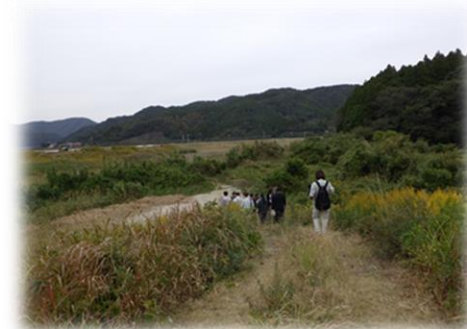
氾濫原霞堤（伊万里市）
