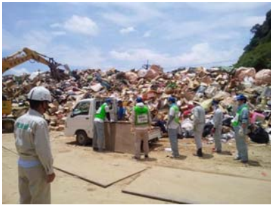
仮置場への搬入状況(7/17)
