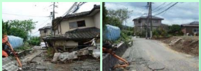
▲倒壊した家屋の解体・撤去の様子 (左)撤去前(右)撤去後
