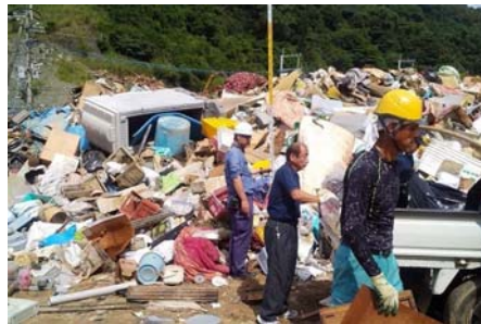
積上げ状況 約2.5m(7/15)
