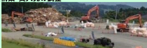
▲二次仮置場の様子
