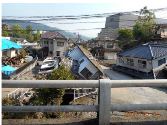
写真-熊本県内の被害状況
