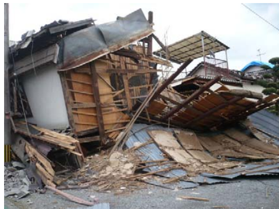
写真-熊本県内の被害状況
