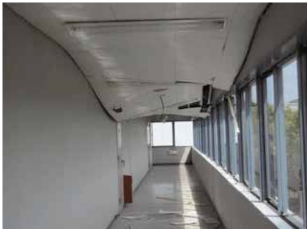
工場棟廊下天井
