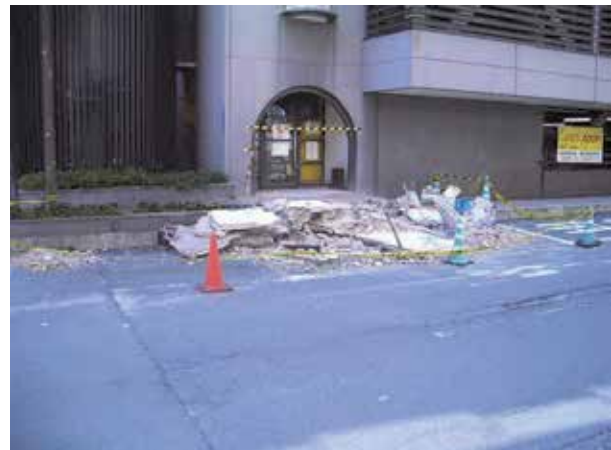
庁舎駐車施設の状況
