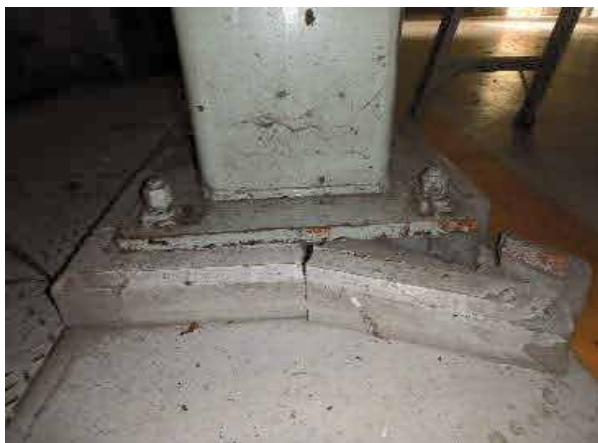
プラント支柱基礎
