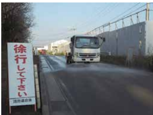
搬入道路の散水
