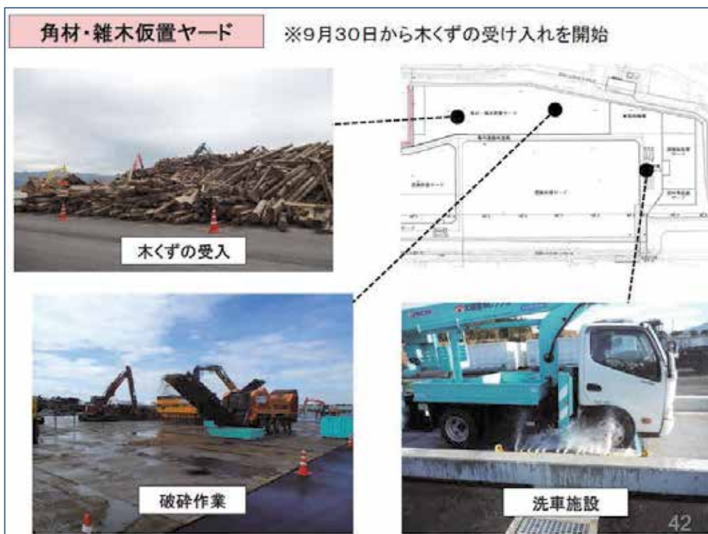
図 5.3.4 角材・雑木仮置ヤードの平面配置と設備
