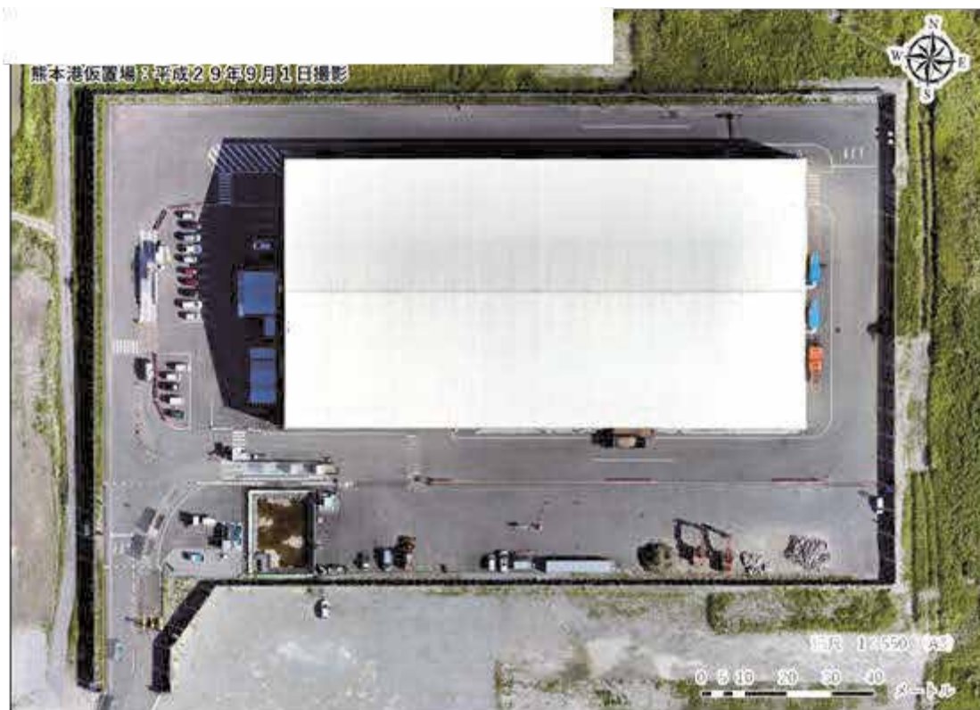
図 5.3.12 熊本港仮置場の配置（航空写真）
