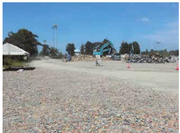
場内の瓦敷設例
