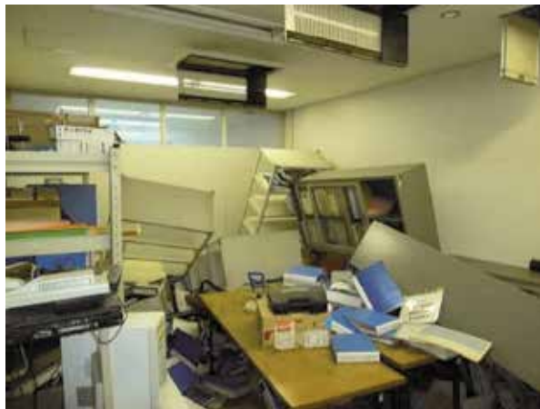
執務室の状況
