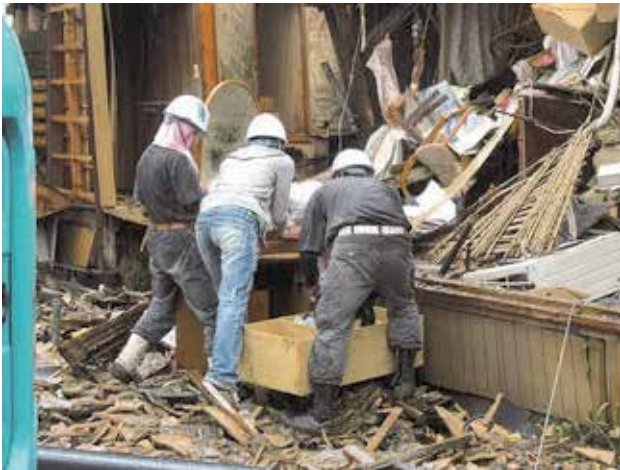
家屋解体状況③
