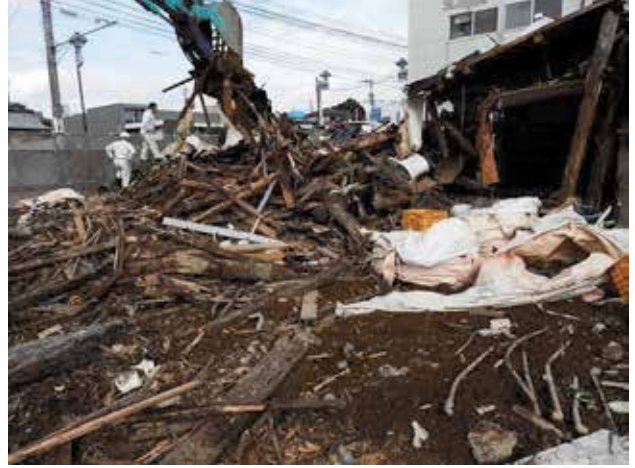
家屋解体状況②
