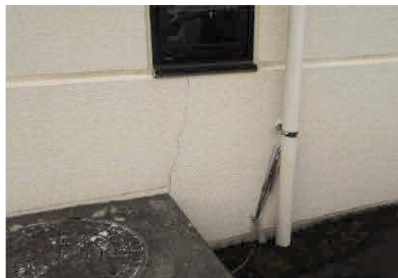
浸出水処理施設外壁
