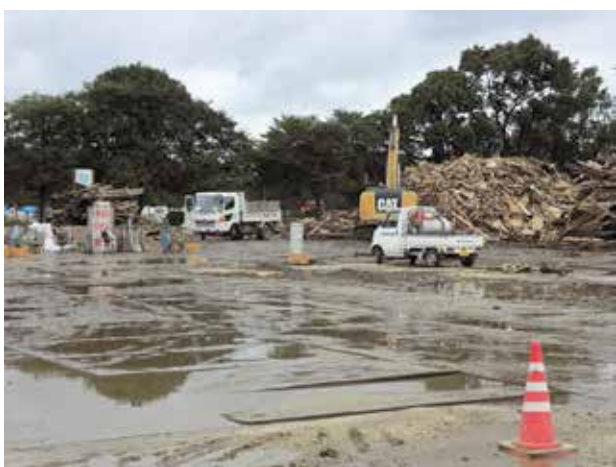
敷鉄板の敷設状況
