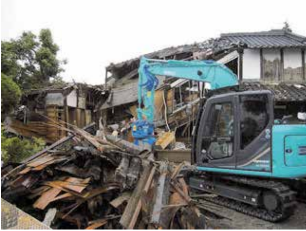
家屋解体状況①
