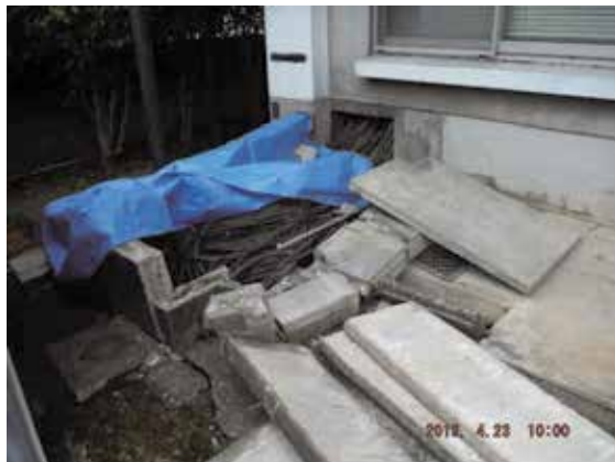
管理棟電線引込部
