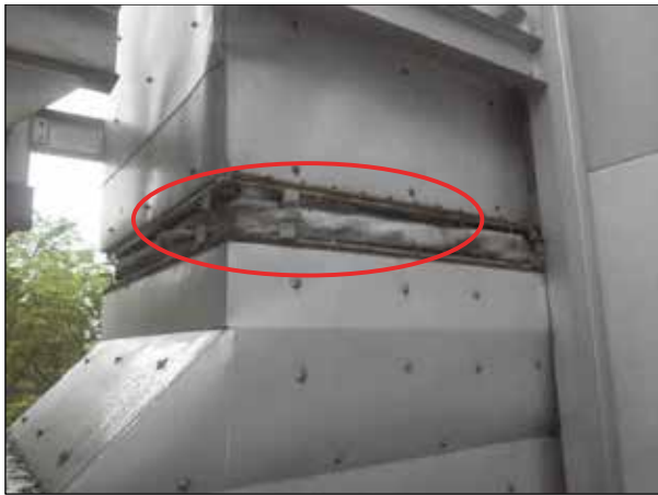
排ガス減温用ダクト継手
