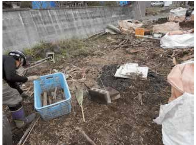
家屋解体状況④
