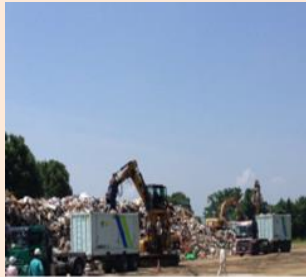
積み込み作業
