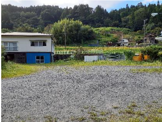
9月21日：由布市 家屋解体用仮置場
