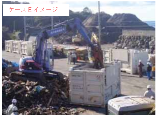
12ft コンテナへの積込状況 (混合廃棄物) [大島町災害相廃棄物処理記録(2015年3月より)]
