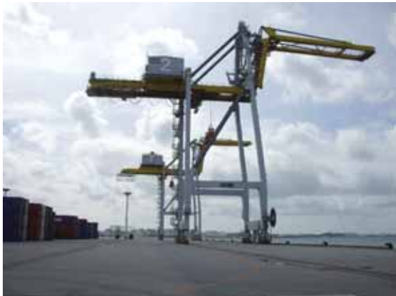
那覇港コンテナターミナルの ガントリークレーン
