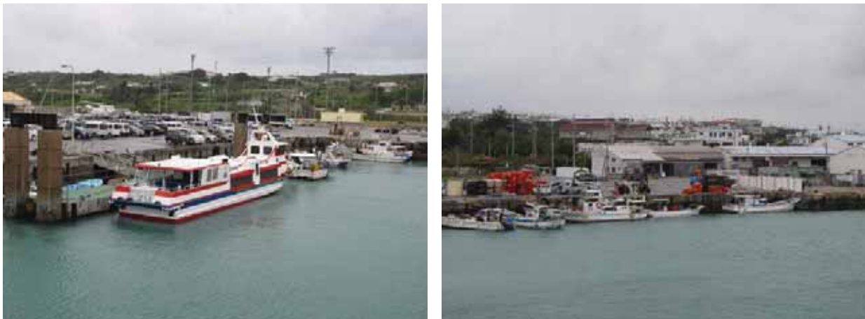
図 4.1-23 平敷屋漁港の状況
