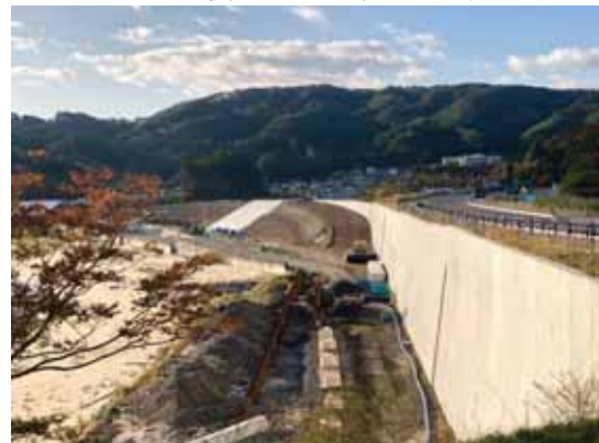
逆T型堤防兼国道擁壁・住宅高台移転
