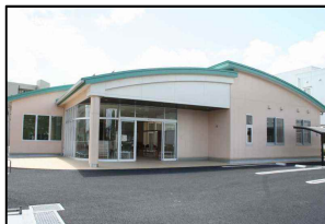
防災力強化の取組 (避難所の整備・改修等)
