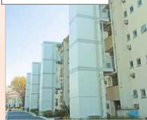
エレベータ設置
