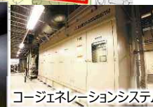
コージェネレーションシステム
