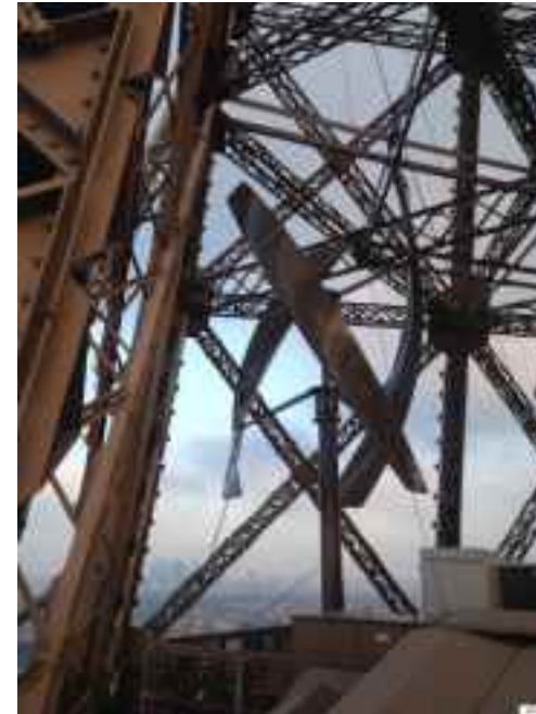
斜め下から見上げる
