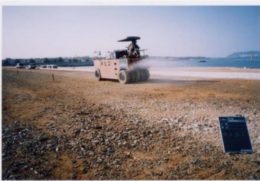
埋立の土砂粉塵飛散防止対策（散水）
