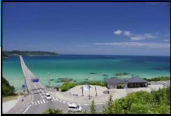
角島大橋(下関市)
