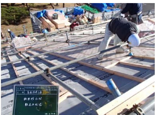
4, 断熱材敷き込
